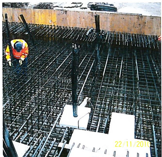
Bild 5 Einbindung der Ankerköpfe in die Pfahlkopfplatte
